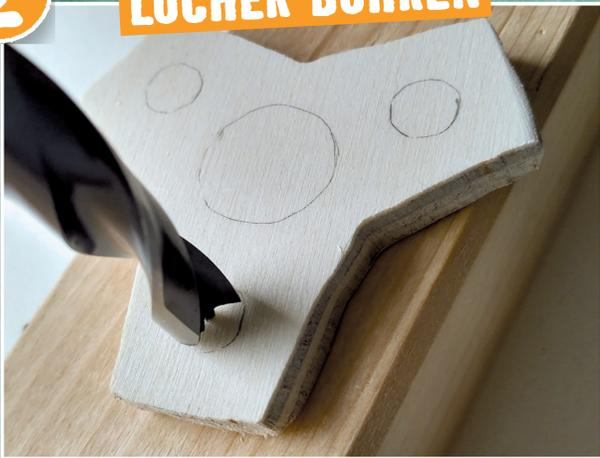
Spanne den Fingerkreisel zum Bohren flach auf einer Holzunterlage fest. Mit einem Erwachsenen zusammen kannst Du jetzt vorsichtig die Löcher bohren: Bohre mit einem 10-mm-Bohrer in jeden Flügel des Spinners ein Loch für die Gewichte.
