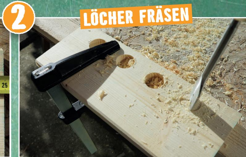
Lege ein Restholz zwischen Holzstück und Arbeitstisch, in das Du bohren kannst. Spanne das Brett mit Schraubzwingen am Arbeitstisch fest. Jetzt kannst Du zusammen mit einem Erwachsenen mit dem Flachfräsbohrer die Löcher bohren.
