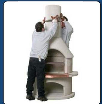
20 Zweiten Kamin Aufsatz positionieren.
