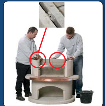
12 Den Feuerbetoneinsatz nach dem Ausrichten mit Kleber am Feuerraumteil fixieren (Detail).
