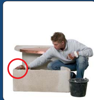
7 Auf das Feuerraumteil punktuell von dem angemischten Kleber aufbringen.
