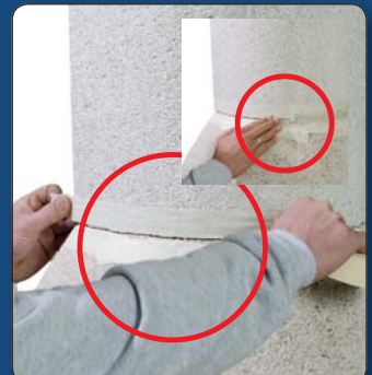
24 Die Fugen zwischen den Kamin Aufsätzen gleichmäßig rundum mit Klebeband abkleben und gleichmäßig mit dem Kleber verputzen. Danach das Klebeband abziehen.
