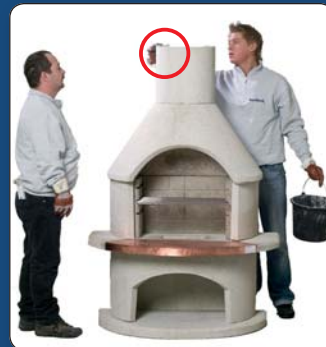
19 Auf den Kamin Aufsatz punktuell den angemischten Kleber aufbringen.
