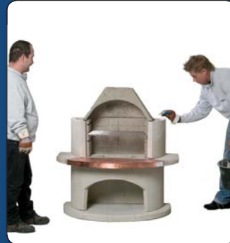
15 Auf das Feuerraumteil punktuell den angemischten Kleber aufbringen.
