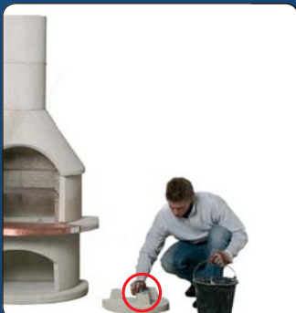
21 Auf die Füße der Kaminabdeckung punktuell angemischten Kleber aufbringen.
