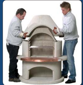
16 Haube auf das Feuerraumteil aufsetzen.
