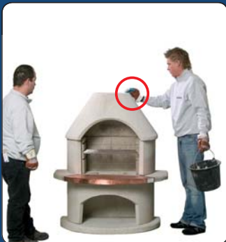
17 Wiederum punktuell den angemischten Kleber aufbringen.
