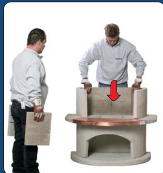
10 Den 3-teiligen Feuerbetoneinsatz von oben senkrecht in das Feuerraumteil einsetzen.
