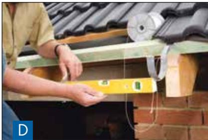
**D** An der Richtschnur das Gefälle noch einmal überprüfen, auf 10 m Dachrinne sollten **2 bis 3 cm Gefälle** eingeplant werden.
