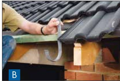
**B** Das erste Rinneneisen an dem Dachstein ausrichten: Die Vorderkante des Dachsteins muss  $\frac{1}{3}$  in die Rinne hineinstehen. Das letzte Rinneneisen mit **2 bis 3 cm Gefälle** auf 10 m montieren.
