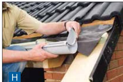
**H** Die Dachrinne mit einer Metallsäge auf die passende Länge zuschneiden und in die Rinneneisen legen. Das Endstück wird einfach aufgesteckt.
