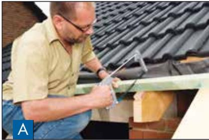
**A** Abstand der Rinneneisen **50 bis max. 70 cm**. Sägen Sie in die erste Dachlatte Schlitz in der Breite des Rinneneisens, Schlitz ausstemmen, damit die Eisen bündig in die Dachlatte eingelassen werden können.
