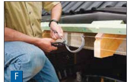
**F** Vor der Befestigung müssen die Rinneneisen abgelenkt werden. Das Abbiegen geht am einfachsten mit einer großen Kneifzange, wie im Bild dargestellt, oder im Schraubstock.
