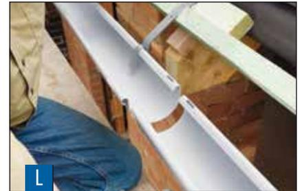
Die Rinnen werden mit einer Verbindungsschale zusammengesteckt. Der richtige Abstand der Rinnenenden ergibt sich aus den Markierungen auf der Verbindungsschale. Wichtig: Bei gekürzter Rinne muss die Nut eingearbeitet werden.
