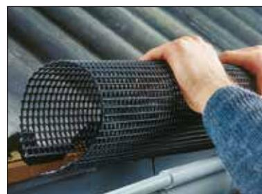
Poly-Net Laubstop-Gitterrohr wird in die Dachrinne eingelegt und klemmt sich durch seine Eigenspannung fest. Leicht zu verarbeiten, da Marley Poly-Net Laubstop in Längen von 2,00 m geliefert wird.
