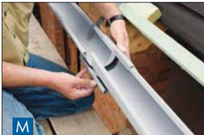
Die Verbindungsschale wird über die hintere Abkantung eingehängt und über den vorderen Wulst geklippt. Markierungen beachten – Nocke-Nut-System!
