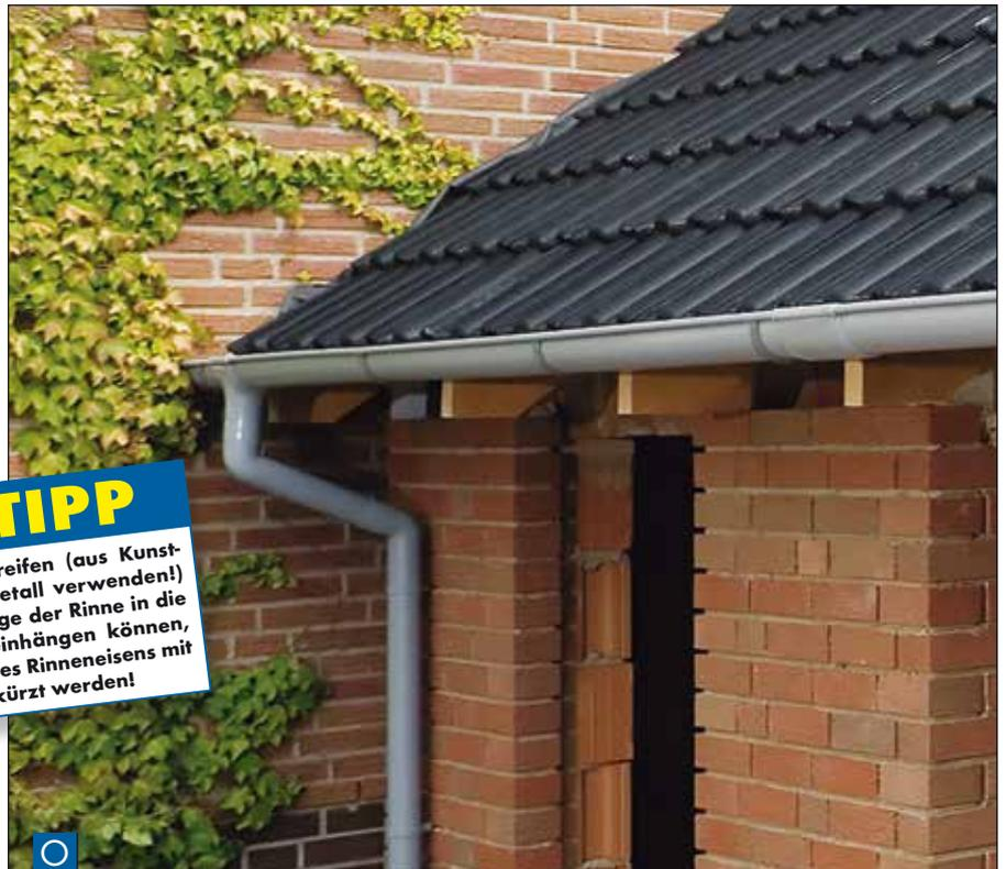
Die fertige Dachrinne bildet einen optisch gefälligen Abschluss für das Dach und schützt Wände und Fundamente vor Feuchtigkeit.
