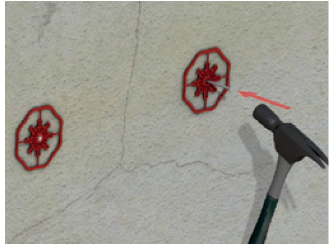
Abb. 15: Setzen der Baumit KlebeAnker mittels Hammer
