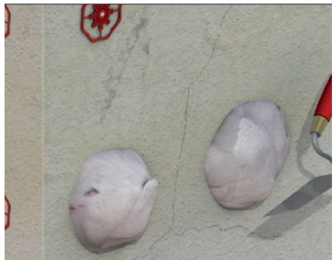
Abb. 17: Anwerfen der Kleberpatzen
