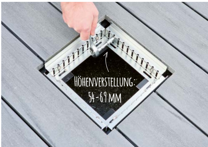
Höhe des Revisionskastens an den Terrassenbelag anpassen.
