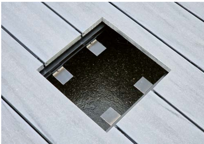
Windlastträger (Art.-Nr. 7517) an der Aluminium-Unterkonstruktion befestigen.
