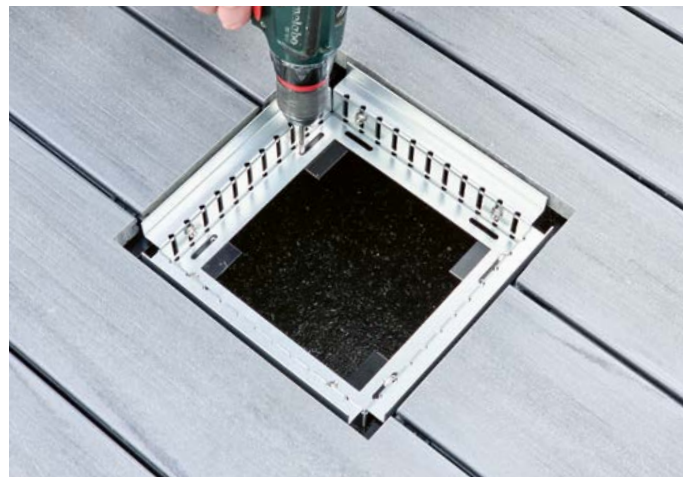
Revisionskasten einsetzen und an Windlastträger verschrauben.
