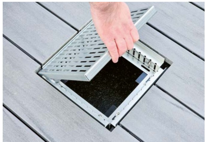
Abdeckblech in den montierten Kasten einlegen.
