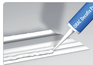
Den Montagekleber auf die Eckleiste auftragen
