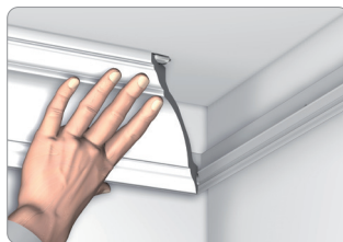
Die Eckleiste an der Schiene und an der Decke befestigen
