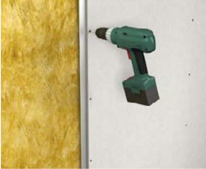
Schrauben auf Metallunterkonstruktion
