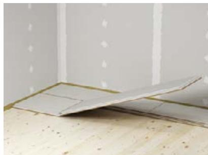
Verkleben der Elemente mit vollständig gefüllten Fugen
