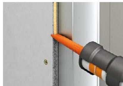
fermacell™ Fugenkleber auf die Plattenkanten auftragen und weiter beplanken.
