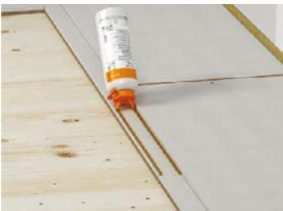
Auftragen des fermacell™ Estrichklebers im Falzbereich
