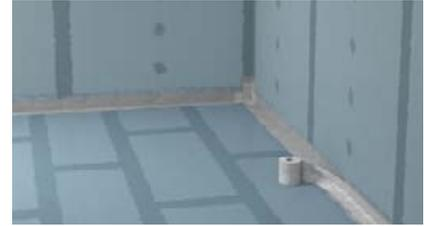
Geeignete Verbundabdichtung in den Anschlussbereichen auftragen und systemkonformes Dichtband eindrücken.
