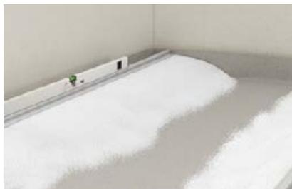
Zwei parallele Dämme in der vorgesehenen Höhe aufschütten. Auf die Dämme dann die Abziehlatten (z. B. fermacell™ Abziehlatten-Set) auflegen.
