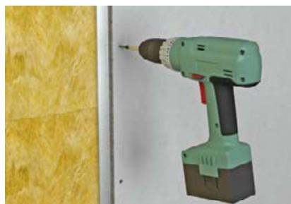
Die Platten mit fermacell™ Powerpanel H<sub>2</sub>O Schnellbauschrauben im Abstand von 20 cm auf der Unterkonstruktion befestigen.
