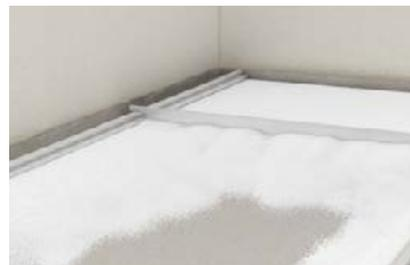
Nach dem Abziehen werden die Abziehlatten entfernt und die fermacell® Estrichelemente verlegt. Zum Schutz der abgezogenen Schüttung sind Laufinseln zu verwenden, z. B. fermacell® Gipsfaserplatten > 500 × 500 mm.
