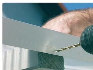
6) Befestigen Sie das Alu-Profil an jeder Querlatte. Die Ø 4 mm großen Bohrungen müssen so positioniert sein, dass die Unterlegscheiben ohne hervorzustehen hinterlegt werden können. Nicht zu weit oben bohren!
