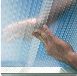
8) Legen Sie die nachfolgenden easy-click plus Hohlkammerpaneele in der Verbindung auf und drücken Sie diese Stück für Stück ein. Es muss hörbar klicken! Kontrollieren Sie unbedingt den korrekten, durchgängigen Verschluss, bevor Sie mit der Verschraubung fortfahren.
