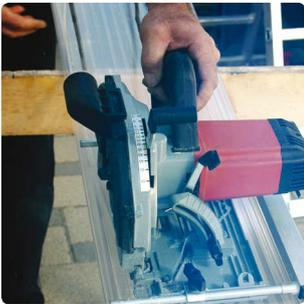
9) Die letzte Paneele wird auf das benötigte Endmaß zugeschnitten. Berücksichtigen Sie bei der Ermittlung der Breite die Überdeckung und den Einschub im Alu-Profil. Klicken Sie die Paneele ein und schieben Sie dann das bereits zugeschnittene Alu-Profil auf. Die Befestigung erfolgt wie unter Punkt 6 beschrieben.
