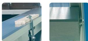
5) Schieben Sie dann die vorbereitete Paneele in das Alu-Profil. Die beiden überstehenden Stege sollten auf ganzer Länge gleichmäßig anliegen. Dann wird das erste Element auf die Unterkonstruktion aufgelegt, exakt im Winkel - in Wasserlaufrichtung! - ausgerichtet und mit Schraubzwingen fixiert. Seitlich muss das Alu-Profil soweit überstehen, dass mind. 2 Unterlegscheiben als Abstandshalter (Abtropfkante) eingesetzt werden können.
