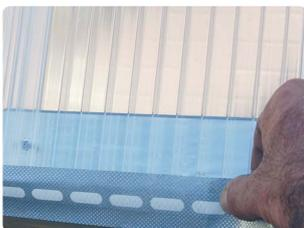
11) Bringen Sie jetzt das Kantenabschlussband am oberen und unteren Ende der Dacheindeckung durchgehend an. Das Band verhindert das Eindringen von Staub, Schmutz und Insekten, lässt aber gleichzeitig die Durchlüftung der Hohlkammern zu.
