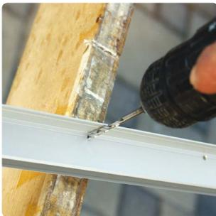
10) Kürzen Sie die Abschlussprofile auf die gemessene Endlänge. Berücksichtigen Sie dabei die Gehrung! Bohren Sie entlang der Nut auf der Unterseite der unteren Profile  $\varnothing$  3 mm große Löcher im Abstand von ca. 10 cm. Diese dienen zum besseren Ablauf von Kondenswasser.
