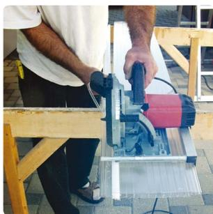
3) Bereiten Sie die erste Paneele vor, indem Sie die Überdeckung abtrennen. Die beiden oberen Stege sollten hierbei ca. 2 mm überstehen.
