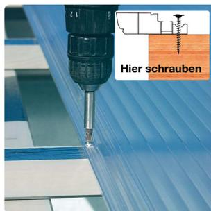
7) Danach werden die Paneele wie abgebildet auf jeder Querlatte verschraubt. Verwenden Sie dafür nur original easy-click plus Schrauben. Ihre spezielle Konstruktion gewährleistet die Funktion und Dichtigkeit der Klickverbindung. Nur bis zur ersten leichten Verformung der Paneele einschrauben. Es muss nicht vorgebohrt werden!
