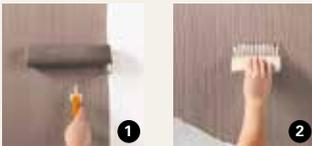
METALL-EFFEKT ist eine Effektbeschichtung zum Auftragen auf Farbrezepte LINIEN-EFFEKT. Farbe vor Gebrauch gut umrühren.
