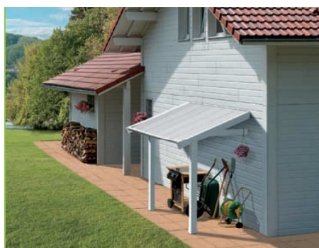
Befestigung an Hauswand
