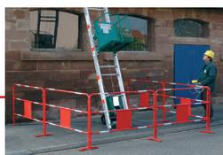
Beim Einsatz unserer Bauaufzüge **muss der Gefahrenbereich unbedingt abgesperrt werden**, um die Sicherheit des Baustellenpersonals zu gewährleisten. Bitte kontaktieren Sie uns bezüglich Absperrungsvorrichtungen.
