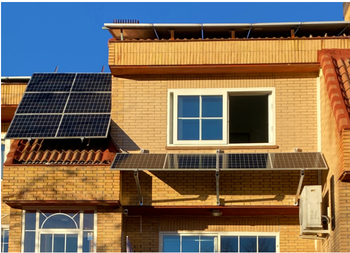
An der Vorderseite des Hauses befinden sich Solarmodule auf allen verfügbaren Dachflächen und ein Solarmarkise.
