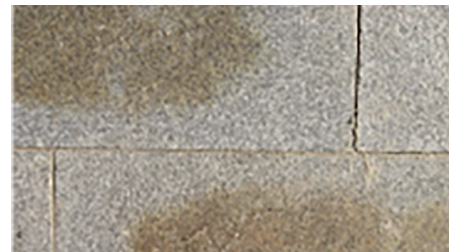
Feuchtigkeitsrückstände (Abb. 1)
