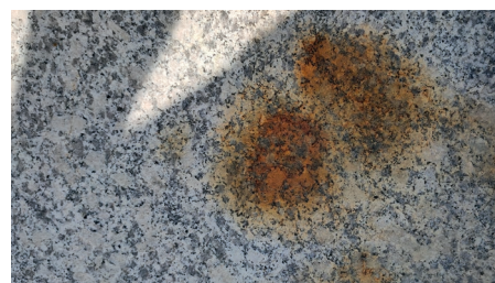
Rostflecken durch Fremdkörper (Abb. 2)
