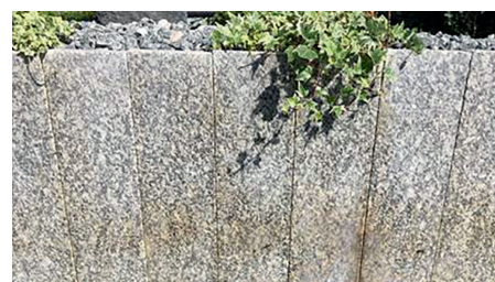
Flecken von Bindemittelrückständen (Abb. 3)
