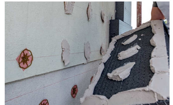
Abb. 24: Randwulst-Punkt-Methode, schematische Darstellung anhand der Baumit FassadenPlatte open air
