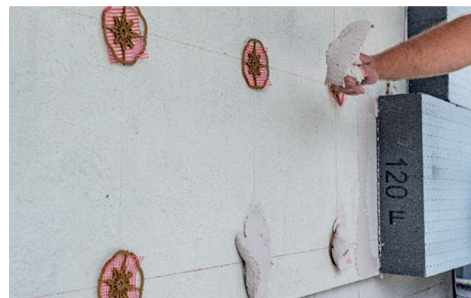
Abb. 23: Anwerfen der Kleberpatzen
