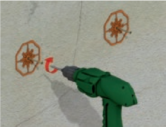
Abb. 22: Setzen der Baumit KlebeAnker mittels Bohrschrauber
