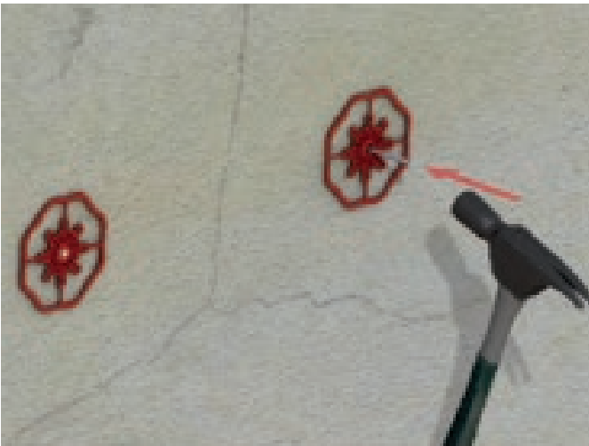
Abb. 21: Setzen der Baumit KlebeAnker mittels Hammer
