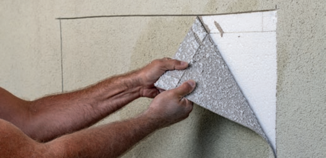
Abb. 7: Untergrundprüfung mit dem öffnen des bestehenden Systems
