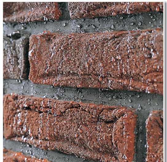
TROCK'NE MAUER: Abperleffekt von imprägniertem Mauerwerk.
