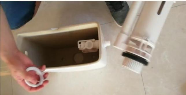
Nehmen Sie die Innengarnitur und setzen die Dichtung (Nr. 8 Dichtung Schwarz klein) über das Gewinde und führen diese durch die vorgesehene Öffnung. Achtung Sie darauf das die gerippte Seite an die Keramik gesetzt wird.
