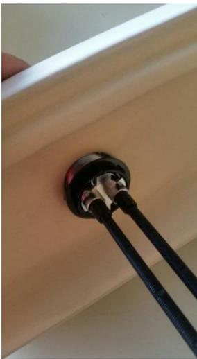
Befestigen Sie den 2-Mengen Drücker (Nr. 5) an der Spülkastenabdeckung (Nr. 3) und setzen Sie den Decke auf den Spülkasten
