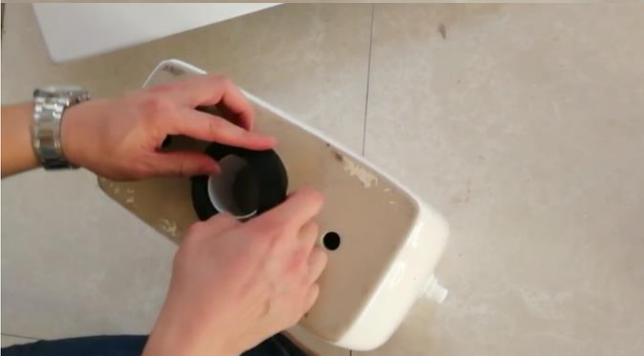
Nach dem setzen der Überwurfmutter stülpen Sie die Dichtung (Nr. 7) über die Überwurfmutter und setzen den Spülkasten auf das Stand-WC. (Tipp. Hier sollten Sie eine weitere Person zur Hilfe nehmen)
