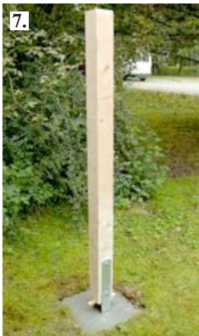
Fertig einbetonierter Pfosten.
