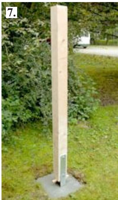
Fertig einbetonierter Pfosten.
