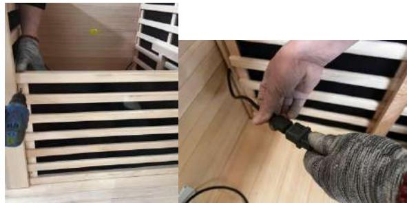
(8) Montieren Sie die vordere Stütze des Stuhls, verwenden Sie 4 Stück 3.5x25mm Schrauben zur Befestigung. Verwenden Sie den Stecker, um den Strom für die vordere Bankheizung anzuschließen, siehe Fotos.
