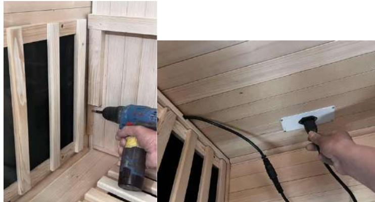
(7) Montieren Sie die Stuhlbankstützen mit 3.5x25mm Schrauben zur Befestigung und verbinden Sie den Kabelstecker für die Stuhlseitenstütze.
