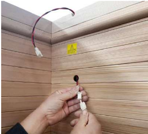
(14) Saunalichtkabel wie oben anschließen.
