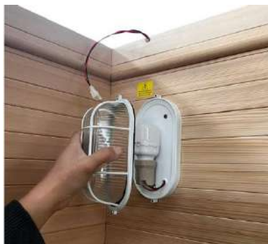
(16) Installieren Sie die wasserdichte Abdeckung des Saunalichts (4x12mm Schrauben)
