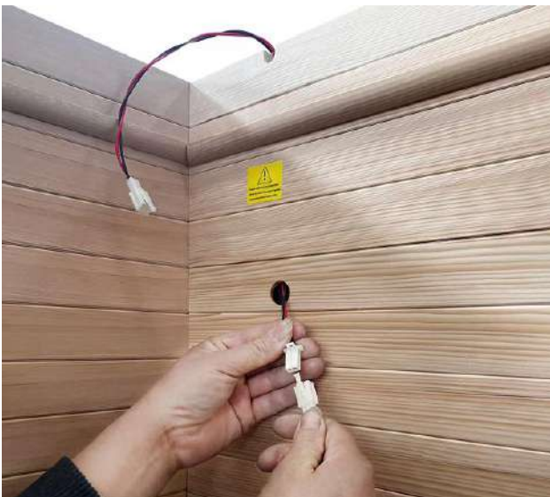
(9) Saunalichtkabel wie oben anschließen.
