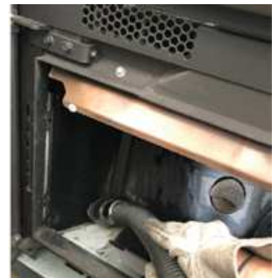
Fig. 30 - Die Asche absaugen
