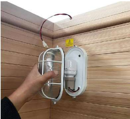
13 Installieren Sie die wasserdichte Abdeckung der Saunaleuchte, verwenden Sie einfach Schrauben, siehe Foto oben Glasschrauben M3x20mm
