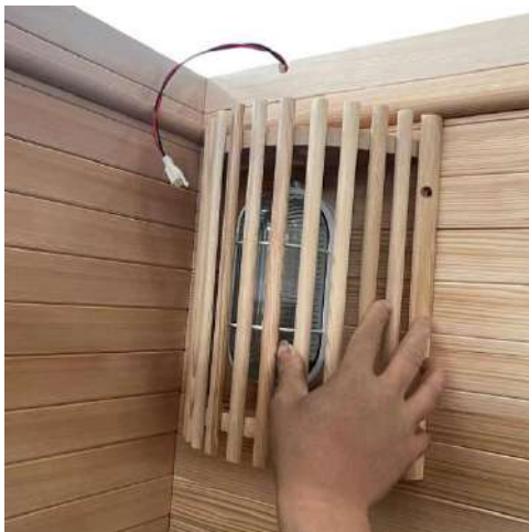
14 Holzabdeckung für Saunaleuchten montieren, Schrauben 3.5x25
