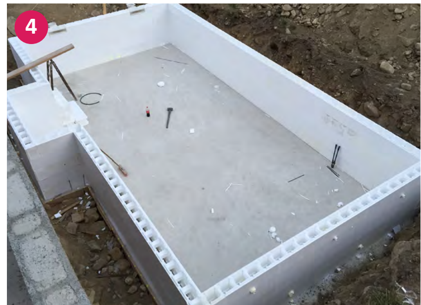
▲ Fertig aufgestelltes Styropor Becken – ohne Betonfüllung
