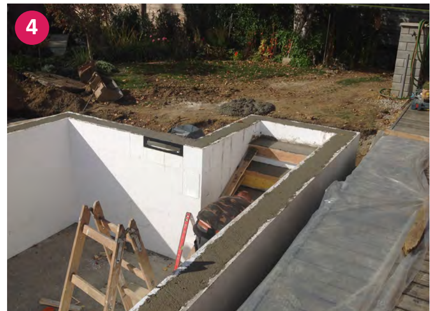
▲ Fertig ausgefülltes Styroporsteinbecken mit Beton
