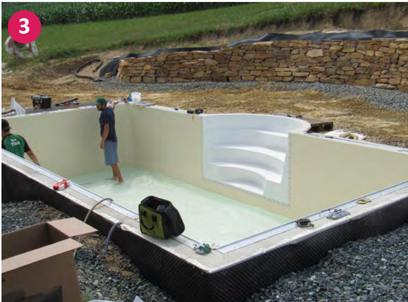
▲ Einhängen des Foliensacks und Anflanschen der Einbauteile
