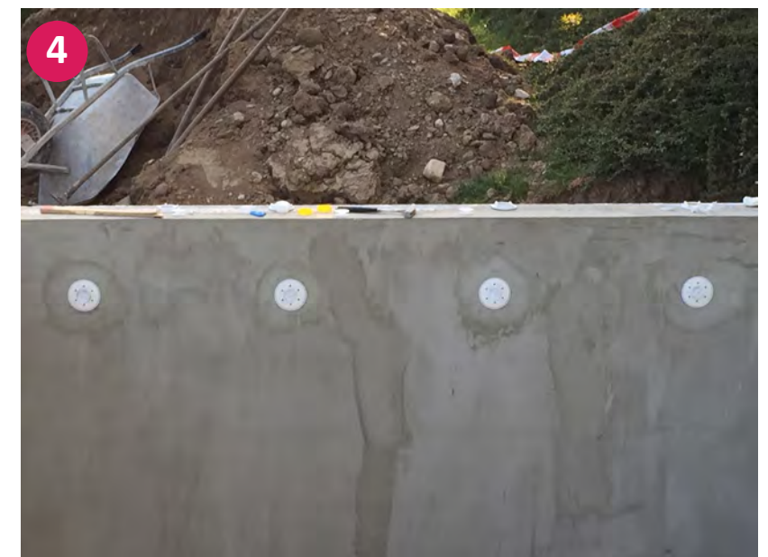
▲ Wichtig: Abdrücken der Rohrleitungen!
