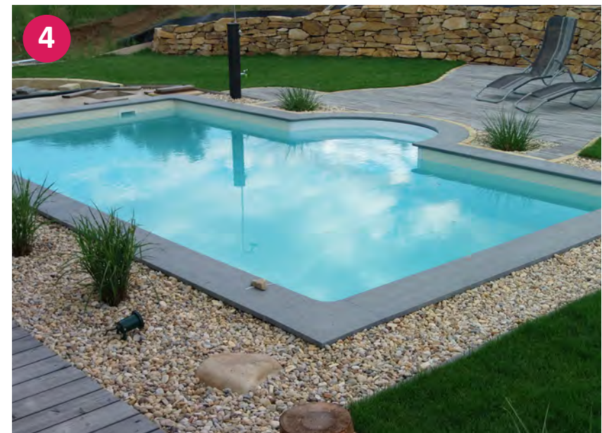
▲ Fertiges Styroporsteinbecken mit Römertreppe
