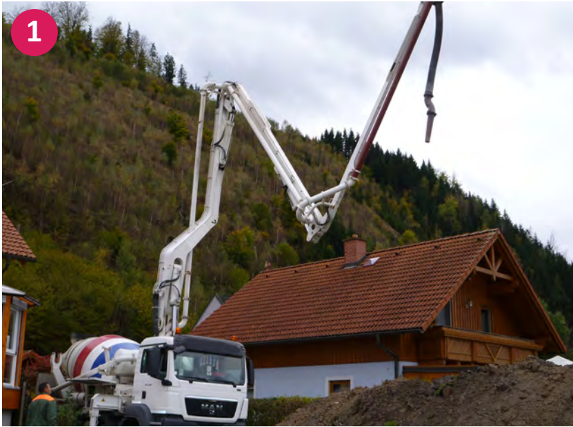
▲ Betonwagen mit Betonpumpe
