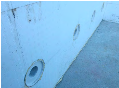
▲ Fertig eingeschäumte Wanddurchführung
