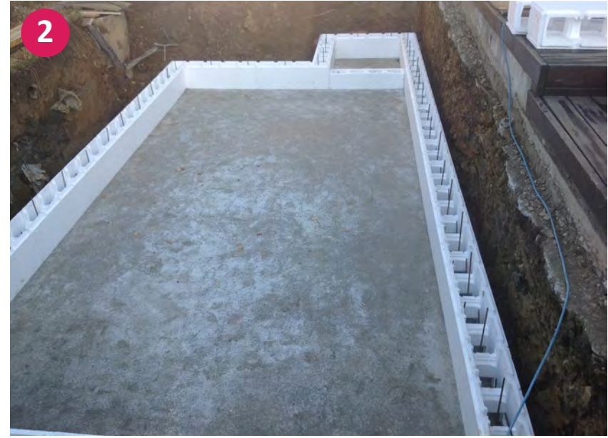
▲ Ansätzen der ersten Reihe Styropor Steine
