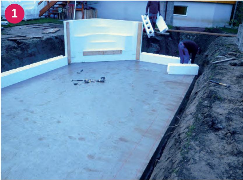
▲ Ecktreppe mit erster Ansatzreihe Styroporsteine
