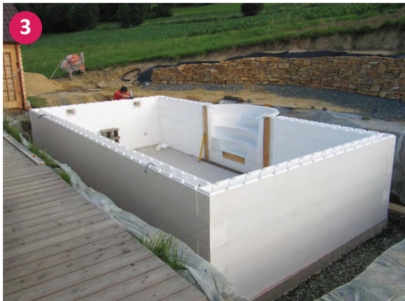
▲ Aufgestelltes Styroporstein Becken mit Römertreppe – ohne Betonfüllung
