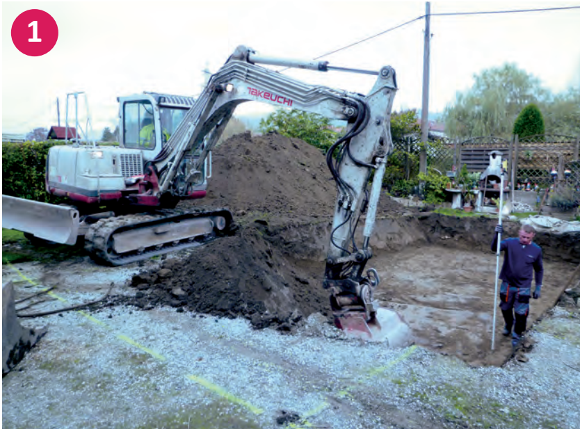
▲ Aushub der Baugrube
