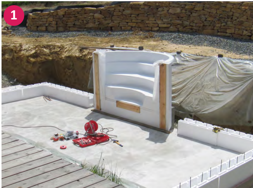
▲ Römertreppe mit erster Ansatzreihe Styroporsteine
