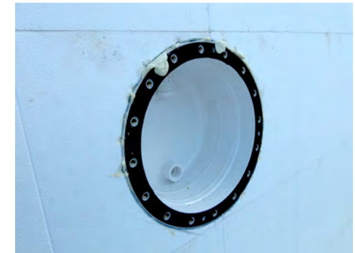
▲ Fertig eingeschäumter Scheinwerfer
