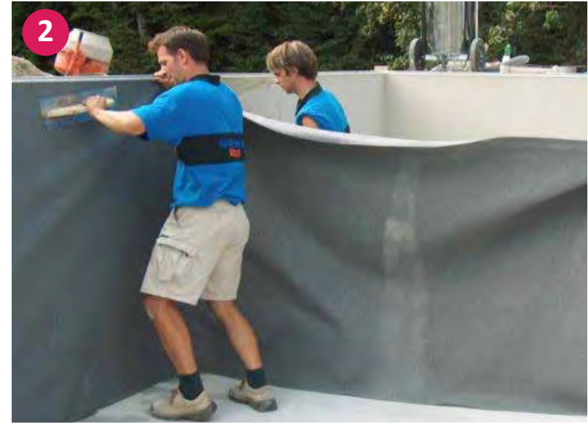
▲ Punktuelle Befestigung der Vliestrennlage mittels Styroporkleber
