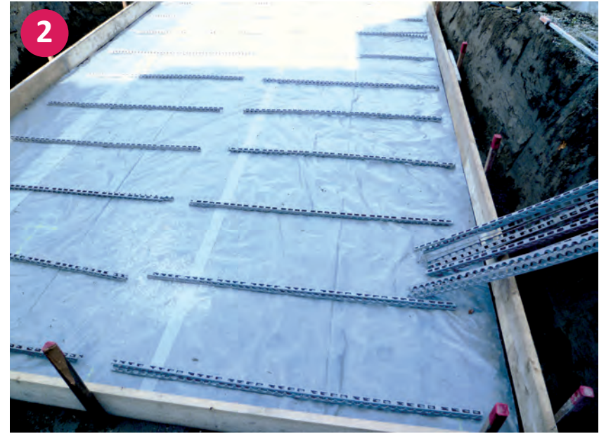
▲ Abschallung der Bodenplatte
