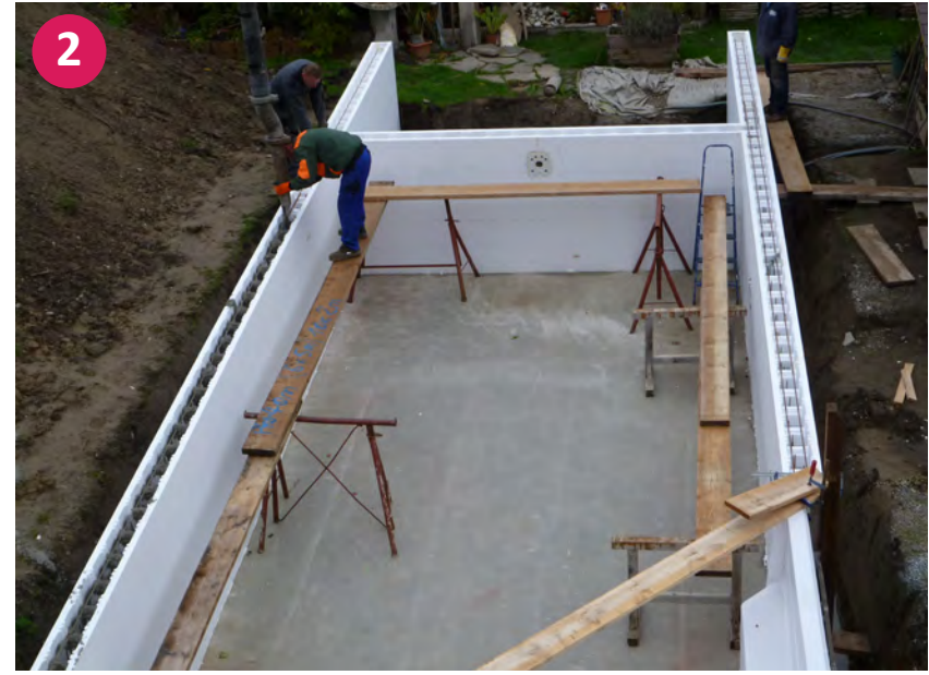
▲ Ausfüllen der Styroporstein mit dem Beton
