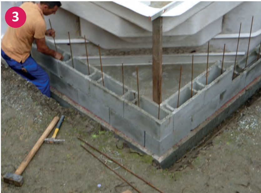
▲ Untermauerung der Ecktreppe
