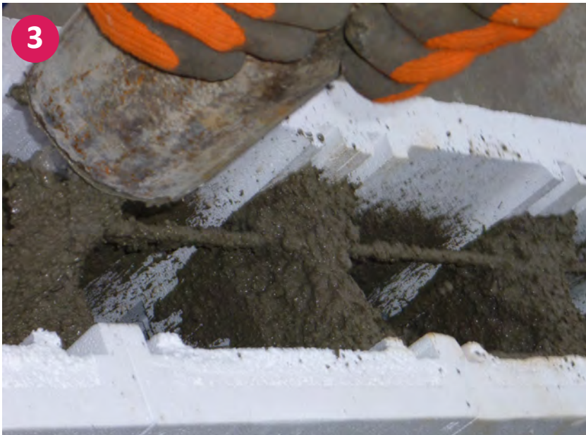
▲ Detailansicht: Ausfüllen der Styroporstein mit dem Beton
