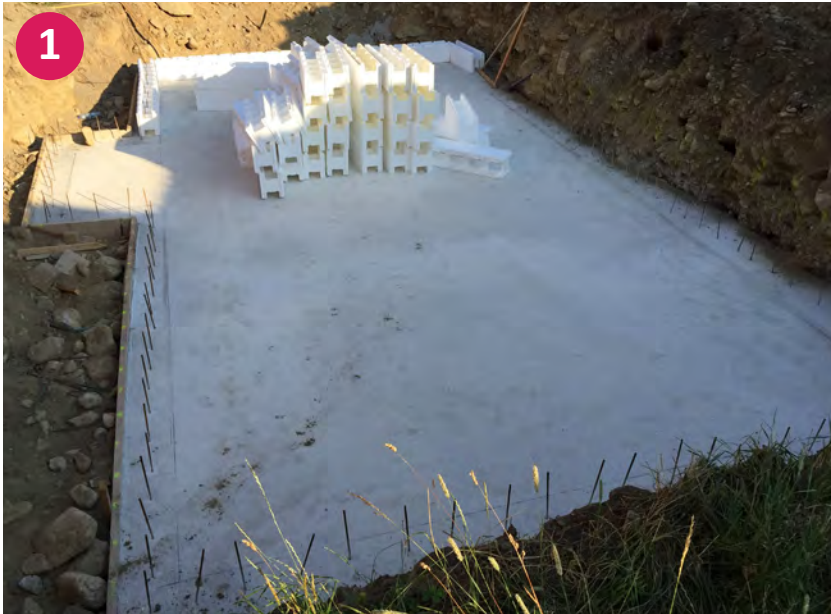
▲ Fertig ausgehärtete Bodenplatte
