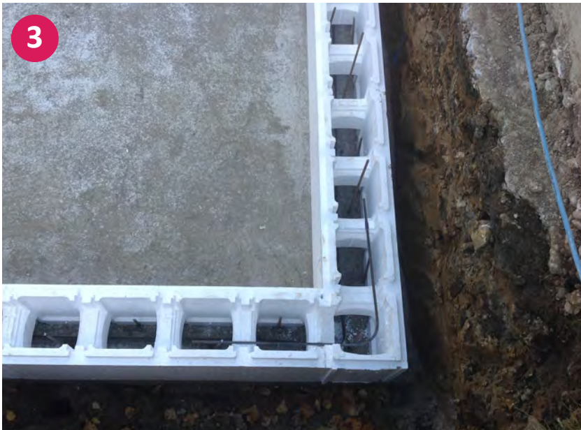
▲ Detailbild einer Eckverbindung samt Eisenarmierung
