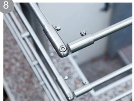
8 Für die Ecken stehen Ihnen Gelenkverbindungen zur Verfügung, die aufgesteckt und mit einem Inbusschlüssel festgezogen werden können.
