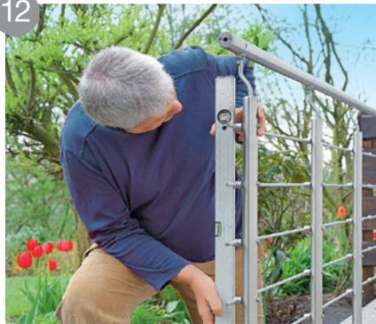
Nun erfolgt die Geländermontage – achten Sie auf eine genaue Ausrichtung.
