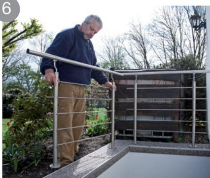
6 Weitere Geländerteile aufstellen, die Handläufe aufstecken und mit Inbusschlüssel befestigen.
