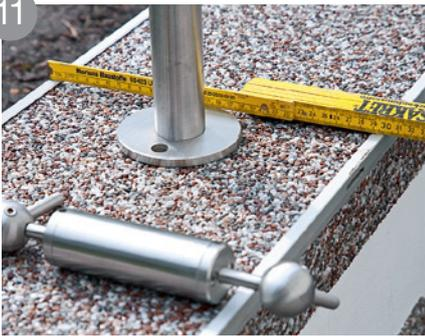
Um das Geländer an einer Treppe oder einer Ecke fortzuführen, steckt man in den Adapter ein Gelenk hinein.
