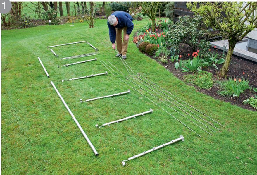
1 Geländerbauteile entsprechend der Geländerform auswählen und auslegen.
