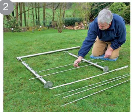
2 Die Rundstäbe (ø 10 mm) durch die Rundstabhalter an den Stützen schieben.
