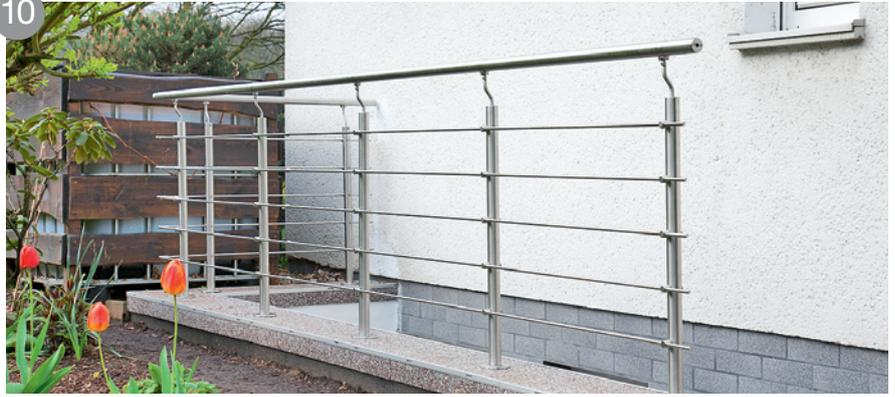
Sind alle Stäbe und Rohre verbunden, können Sie das Geländer ausrichten, ggf. die Befestigungen erneut lösen und die Stäbe und Rohre passend verschieben.
