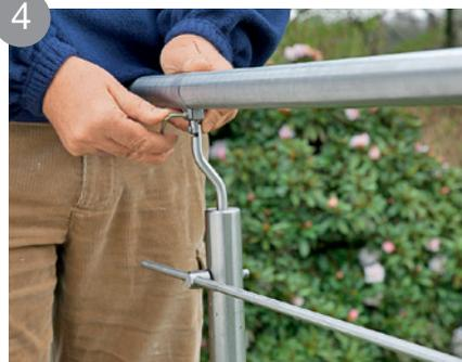
4 Stellen Sie ein Geländerteil an ungefährender Position auf und befestigen Sie den Handlauf (ø 40 mm) an den Stützen.
