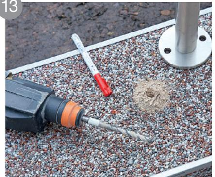
Alle Bohrlöcher durch die Montageplatte hindurch anzeichnen, Geländer abrücken und Löcher bohren.
