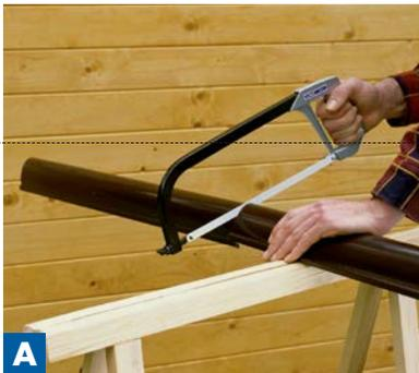
**A** Die Duplex-Dachrinne wird mit einer feinzahnigen Säge auf Länge gesägt.
