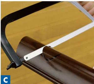
**C** Die Öffnung wird ausgesägt und die Sägekante entgratet.
