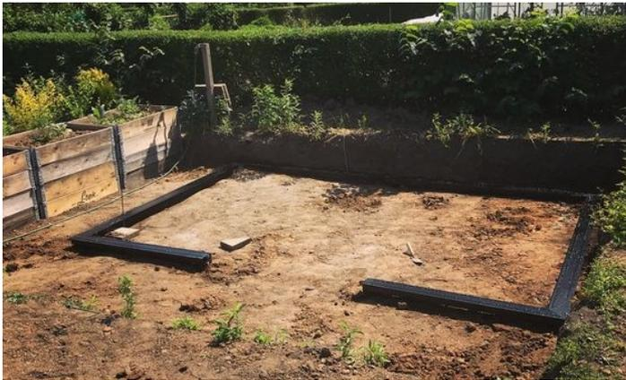
1) Ist ein passender Platz ausgesucht, muss der Fundamentrahmen im Lot/Wasserrecht liegen. Nun kann der Fundamentrahmen punktuell betoniert werden.
