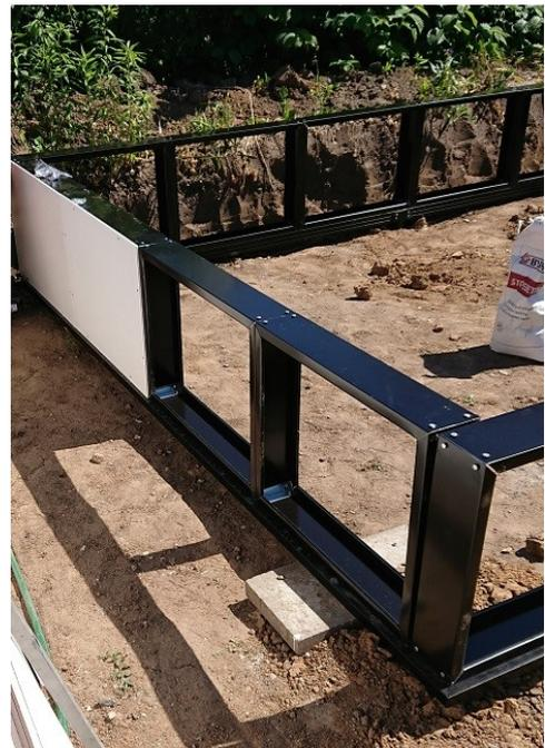
2) Die Profilstücke werden auf dem Fundamentrahmen platziert und die Module von dort aus aufgebaut.
