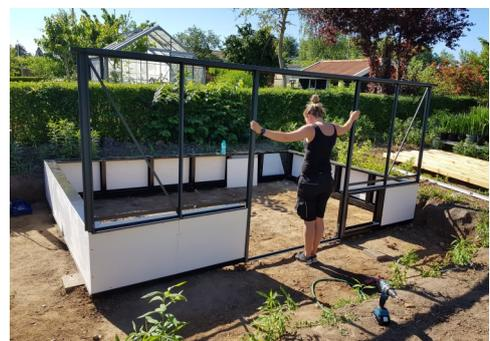
Die Teile des Gewächshauses werden zusammenschraubt und auf der bereits vorhandenen Halbmauer montiert.
