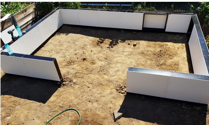
3) Die Modulelemente werden innen und außen auf die Profilrahmen geschraubt.
