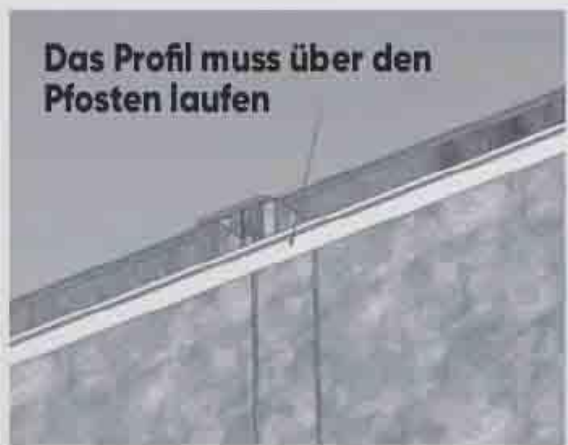
Das Profil zwischen 2 Pfosten platzieren
