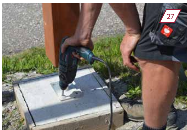
Stützfuß mit Betonfundament verschrauben.
