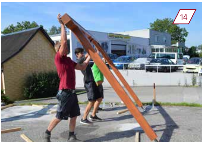
Vorderwand aufstellen. Die Stützfüße wieder auf den Betonfundamenten platzieren.
