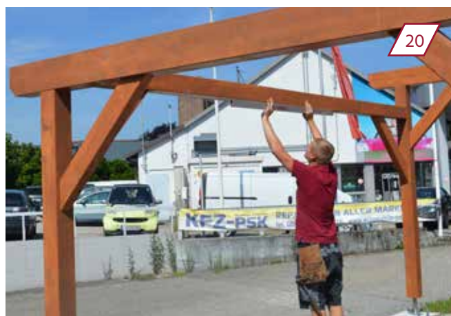
Mit Wasserwaage die Querlatten und Säulen ausrichten.
