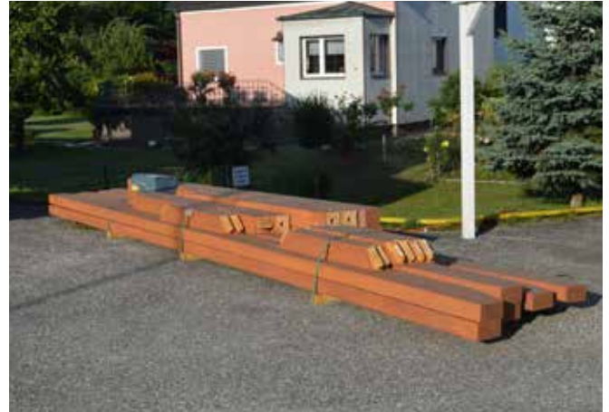
Gelieferte Holzbalken: Hier wurden die Balken vorab gestrichen.
