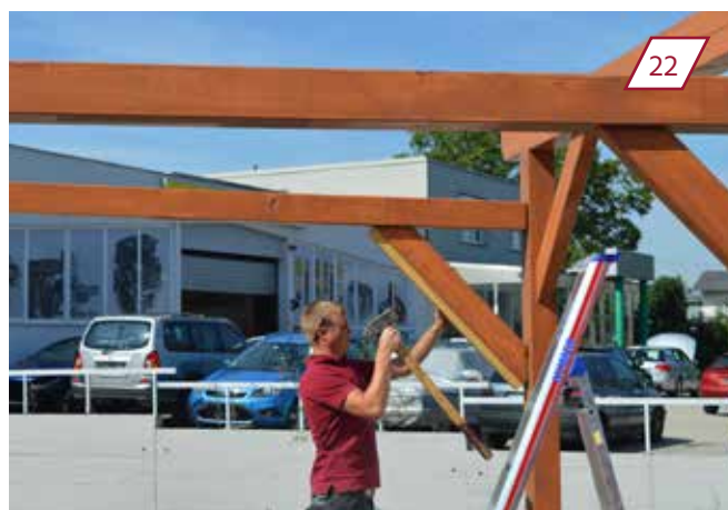
Gegebenenfalls mit Schlaghammer und Latte anpassen.
