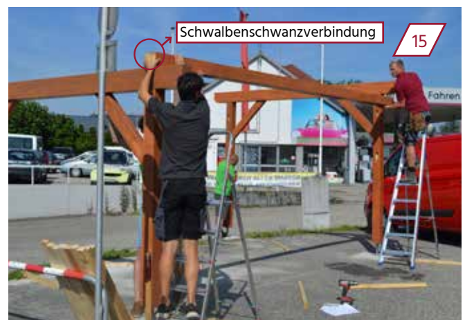
Den seitlichen Pfosten zwischen Rückwand und vorderer Wand anbringen. Auf der niedrigeren Seite die Schwalbenschwanzverbindung hineinschieben.
