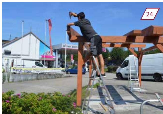
Sparren beiden Enden am Pfosten anschrauben.
