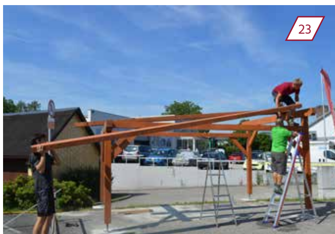
Die Dachsparren auf das Grundgerüst legen.
