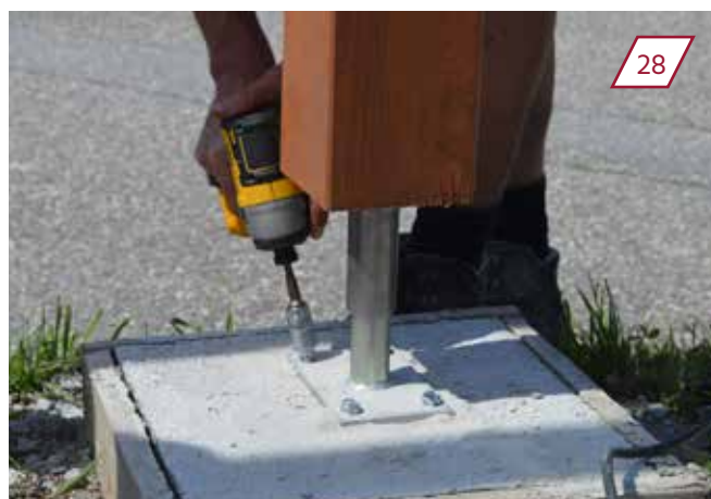
Betonschrauben mit Schlagschrauber oder Gabelschlüssel festschrauben.
