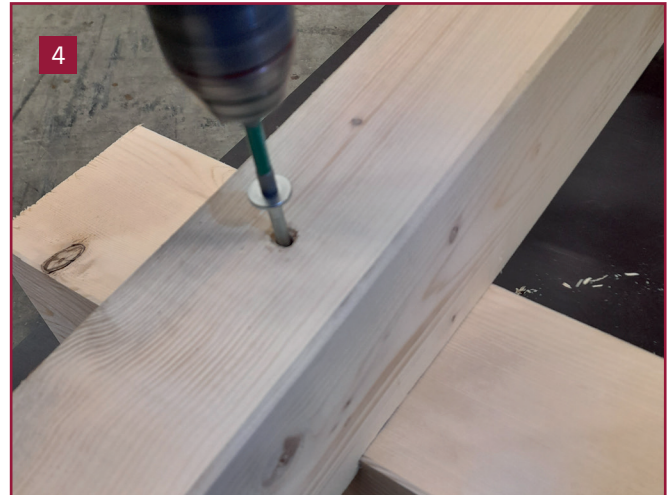
Sparren mit Balken verschrauben.
