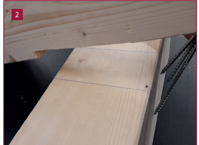
Sparren an markierte Stelle positionieren.
