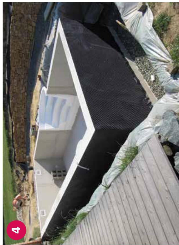
▲ Styroporstein Becken mit Römerstiege, verspannte Innenwände und Noppenbahn außen
