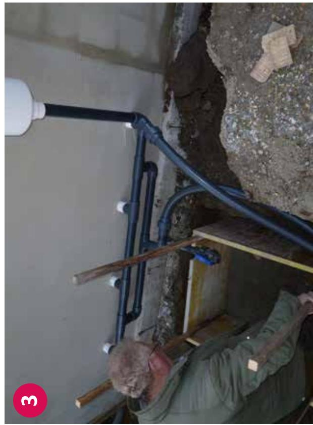
▲ Verrohrung von Düsen, Skimmer und Bodenablauf
