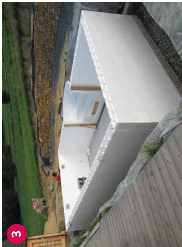
▲ Aufgestelltes Styroporstein Becken mit Römerstiege – ohne Betonfüllung
