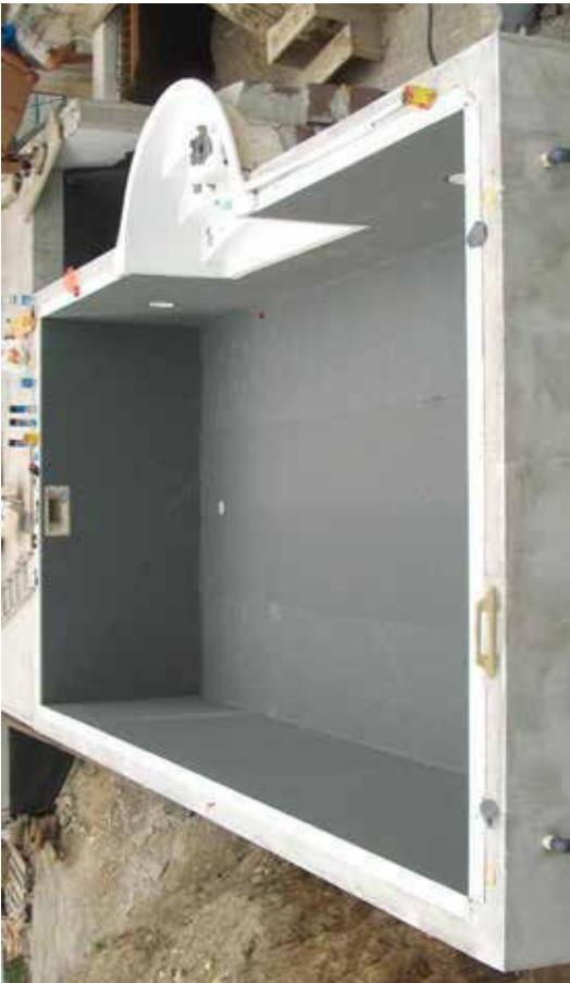
Bei der Montage des Vlieses beginnen Sie am besten mit den Beckenwänden, streichen Sie von den Ecken ausgehend die Wand mit Styropoleber punktuell ein und befestigen nun das Vlies unmittelbar unterhalb des Folieneinhängeprofils. Eventuell am Boden überstehendes Vlies nicht abschneiden, sondern als Übergang zum Bodenvlies als doppelte Lage stehen lassen.
