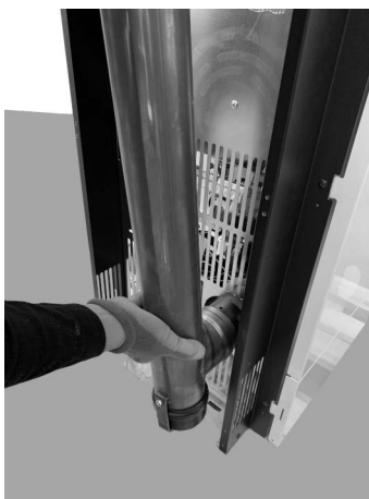
Fig. 41 - Rohr Durchm. 80 mm einstecken
