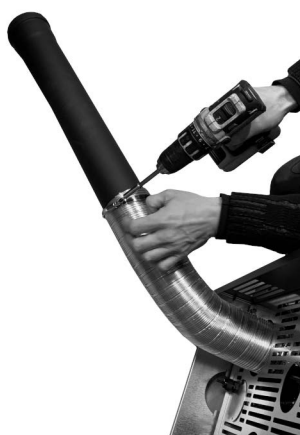
Fig. 61 - Rohr D. 80 mm anschließen
