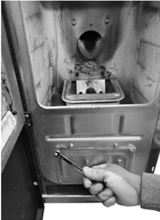
*Fig. 67 - Die Schrauben entfernen*
