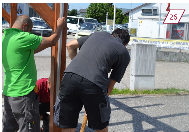
Säulen nochmals mit Wasserwaage, Schlaghammer und Latte ausrichten.
