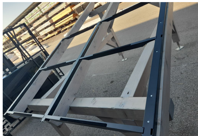
Bei Doppelcarports zusätzlich je einen Querriegel mittig auf Keil positionieren.
