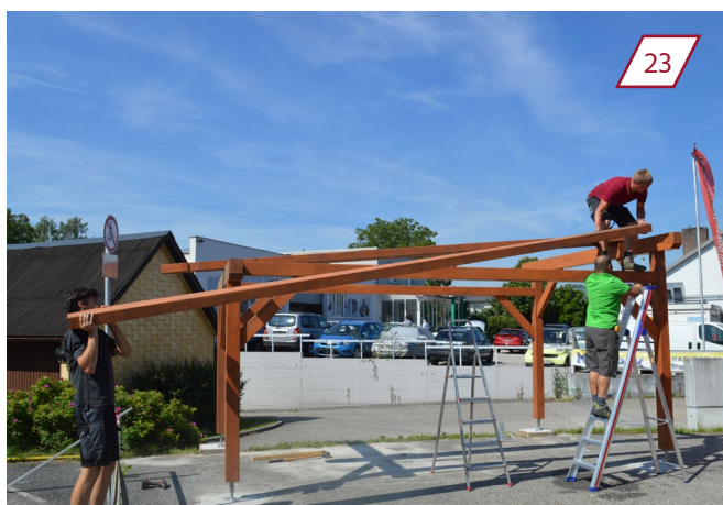
Die Dachsparren auf das Grundgerüst legen.
