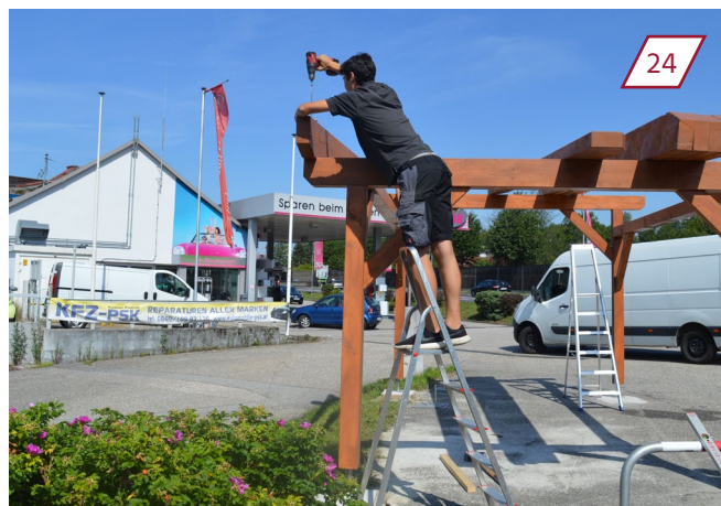
Sparren beiden Enden am Pfosten anschrauben.
