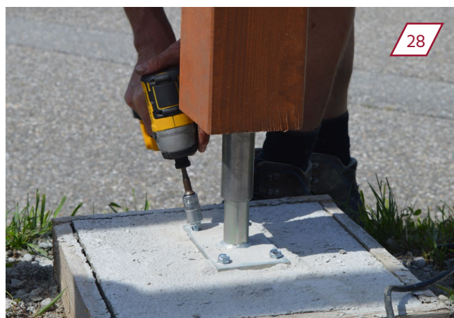
Betonschrauben mit Schlagschrauber oder Gabelschlüssel festschrauben.
