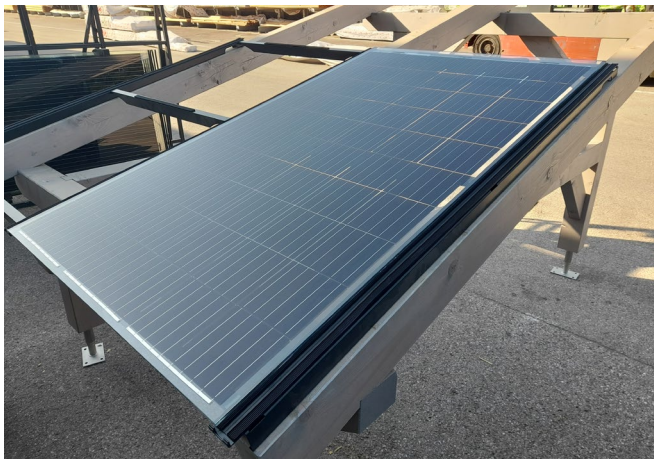
Modul mit Steckern Richtung First mittig zwischen die Sparren auflegen. Stecker zeigen dabei nach unten, die Schlauchdichtung nach oben.
