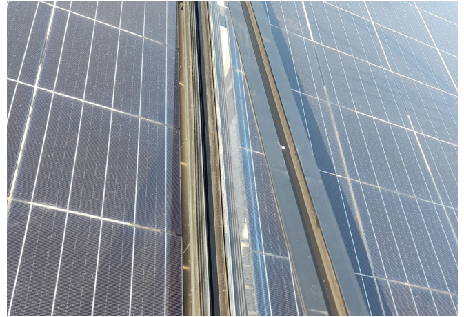
Pressleisten anbringen. Achtung, Pressleisten für die Firstreihe sind länger!
