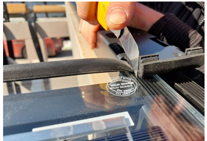
Mit Cuttermesser einen bündigen Schnitt machen. Achtung, nicht komplett durchschneiden sondern nur bis zum unteren Steg der Glasdichtung.
