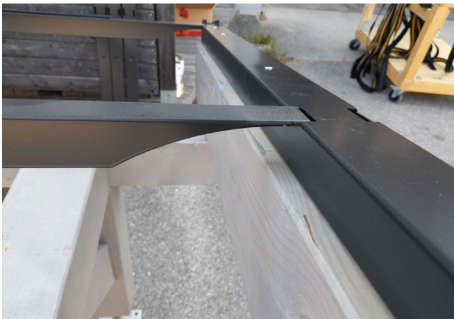
Platzierung in Ausnehmung rechts.
