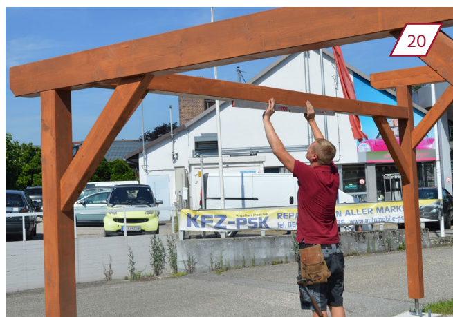
Mit Wasserwaage die Querlatten und Säulen ausrichten.
