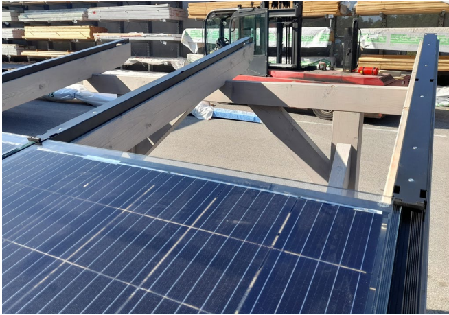
Zweite Keilreihe Stoß an Stoß an erste Keilreihe anbringen und verschrauben. Aufkantung zeigt wieder Richtung Traufe.
