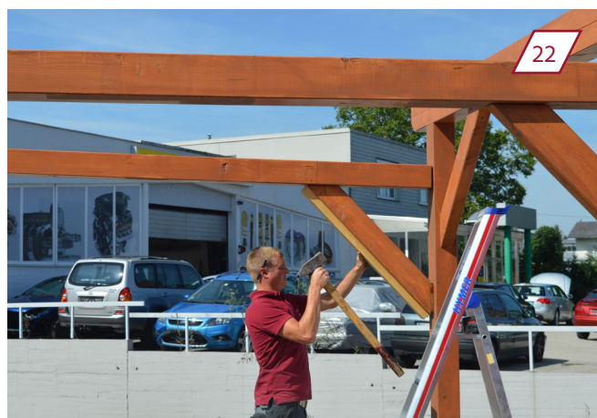
Gegebenenfalls mit Schlaghammer und Latte anpassen.
