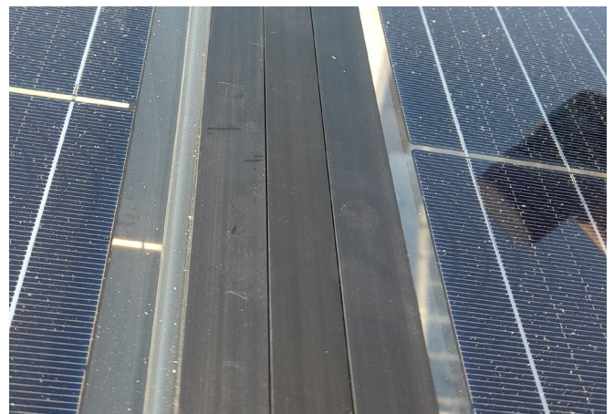
Montierte Pressleiste inklusive Klipsabdeckung.
