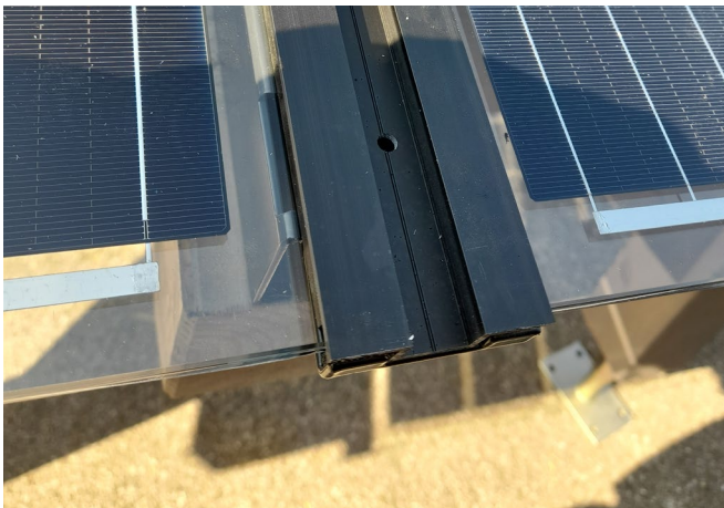
Pressleiste Abschluss mit Glasprofilen.
