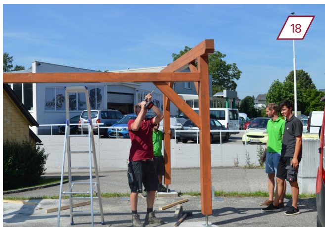
Kopfbänder an den Seitenwänden ergänzen und anschrauben. Danach den oberen Pfosten ganz festschrauben.
