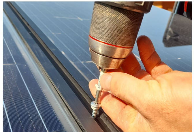
Pressleisten anschrauben. Die Pressleisten dabei gegen die Dichtung drücken.
