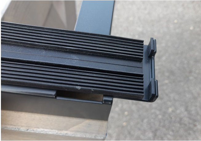
Auflagegummi mit ca. 8 mm Abstand zur Aufkantung unten aufkleben.
