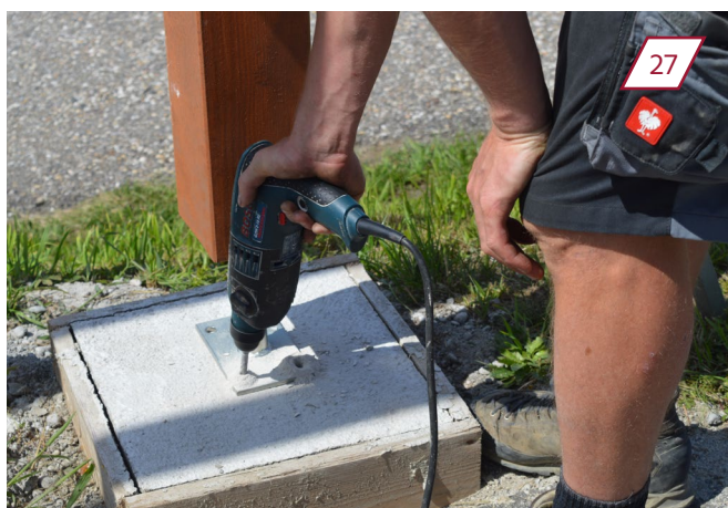
Stützfuß mit Betonfundament verschrauben.
