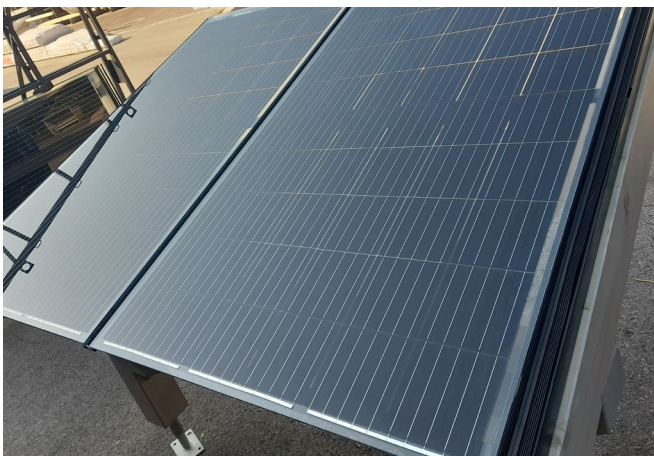
Die restlichen PV-Module der Reihe gleich anbringen.
