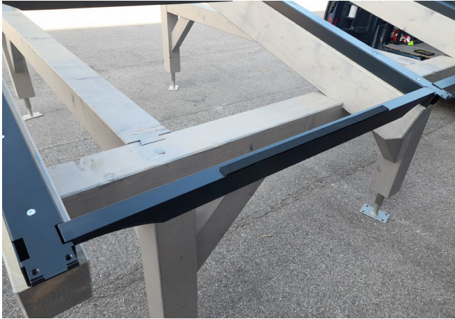
Querriegel jeweils auf untere und obere Kante des Keils in die Ausnehmung legen.
