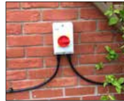
Dreh-Trennschalter (abgebildet). Stellen Sie sicher, dass Sie die Elektrik von einem qualifizierten Elektriker vorbereiten lassen. Lassen Sie 5 Meter Spielraum für den Anschluss an den Whirlpool.
