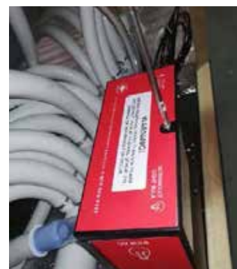
8. Schritt: Rote Abdeckung wieder festschrauben
