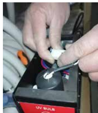
7. Schritt: Weisse Verbindungsstücke wieder verkuppeln
