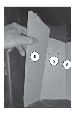
• Über der Vermiculite-Heizgasumlenkung befindet sich eine Heizgasumlenkung aus Blech. Diese leicht anheben (A) und nach hinten aus der Bajonetthalterung schieben (B).
