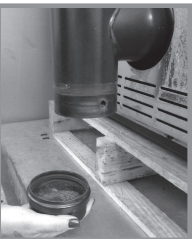
Abb. 6b: Reinigung des Brenntopfes
