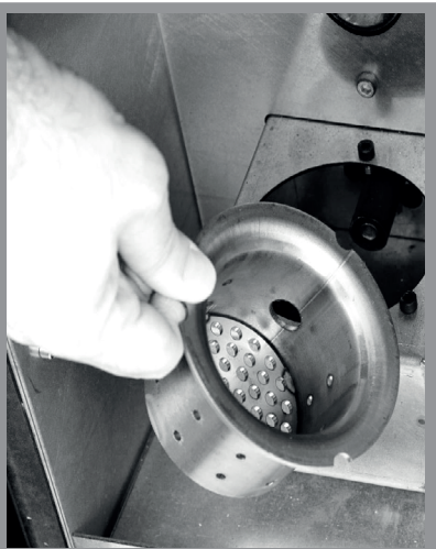
Abb. 5b: Reinigung des Brenntopfes
