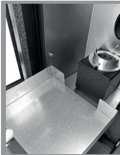
Abb. 5a: Reinigung des Aschekastens
