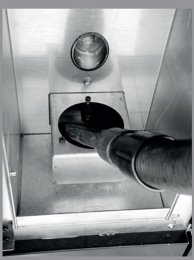
Abb. 5f: Reinigung des Brenntopfes
