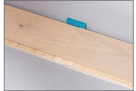
Mit Hilfe von den Kunststoff-Rastkeilen zu allen Wänden und festen Objekten im Raum einen Abstand von mindestens 10 bis 15 mm einhalten.
