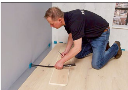
Mit Hilfe eines Reststücks oder des Parador MultiTools wird der Wandverlauf auf die letzte Dielenreihe übertragen.
