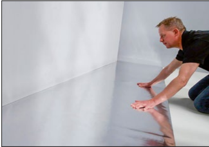
Verlegeunterlage auf vorbereitetem Untergrund auslegen.
