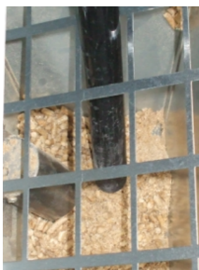
Fig. 60 - Reinigung Tank und Schnecke
