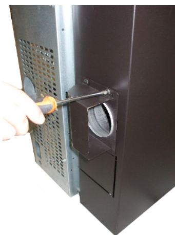
Fig. 50 - Montage der Austrittsdüse
