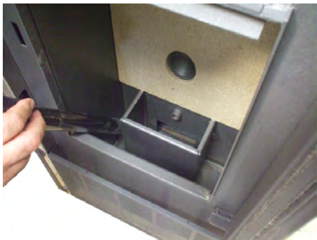
Fig. 58 - Reinigung Fach Brennschale
