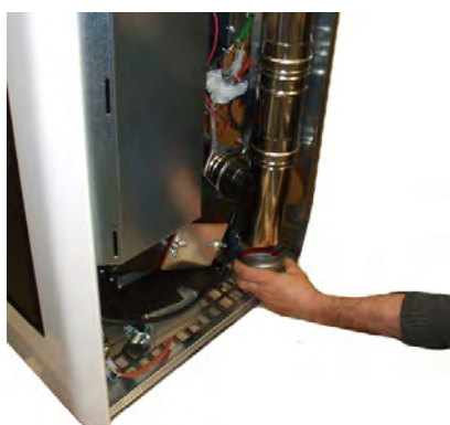
Fig. 82 - Reinigung des Rauchgaskanals
