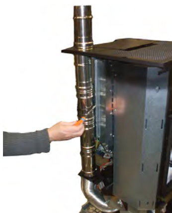
Fig. 45 - Positionierung der Rohre für oberen Kanal
