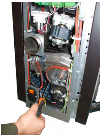
Fig. 84 - Reinigung Rauchgasansauggerät: Phase 1
