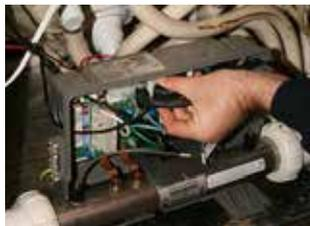
**6. Schritt:** Entfernen Sie die Kabelklemme – ziehen Sie den Pumpenstecker von der Leiterplatte heraus. (Versichern Sie sich, dass die Kabelbinder von den Leitungen entfernt wurden.)
