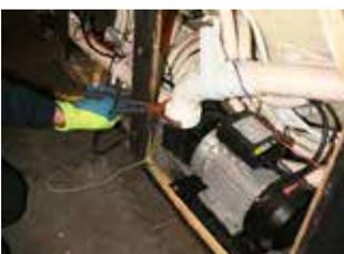
**9. Schritt:** Öffnen Sie die Pumpenverbindungsstellen mit einer Öl-Filter-Greifzange, die in großen Baumärkten erhältlich ist.
