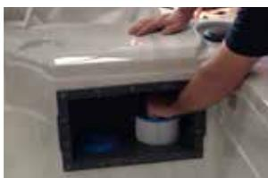
**Schritt 3.** Schrauben Sie die Filter heraus
