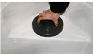
**Schritt 2.** Um den Korb herauszuheben, drehen Sie die Vorrichtung gegen den Uhrzeigersinn, bis Sie ihn herausnehmen können.
