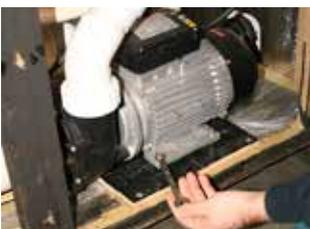
**8. Schritt:** Lösen Sie alle 4 Schraubmuttern vom Sockel der Pumpe mit einem 13 mm Schraubenschlüssel.
