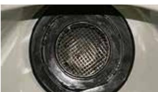
**Schritt 1.** Der Filterkorb kann sowohl bei befülltem oder leerem Pool entfernt werden. Ist der Pool voll Wasser, ist es sinnvoll, einen Lappen o.ä. zur Hand zu haben, um den evtl. austretenden Schmutz aufzufangen, bevor er ins Wasser gelangt.
