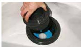
**Schritt 3.** Entfernen Sie den Korb
