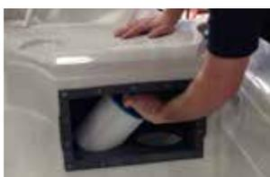
**Schritt 4.** Entnehmen Sie die Filter
