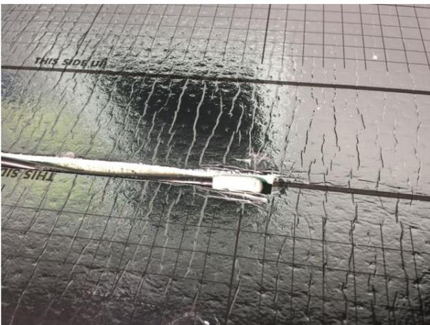
**Abbildung 4: Einlegen des Bodensensors**
