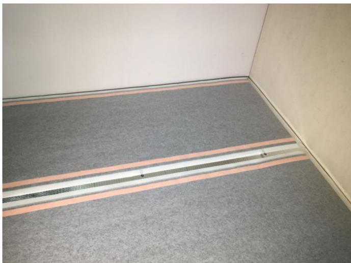
**Abbildung 6: Verlegen der eThermoHeld • BODEN • Heizbahnen**
