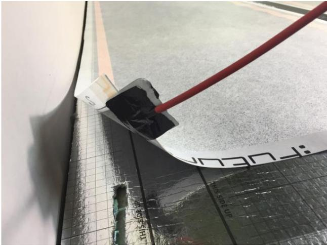
**Abbildung 10: Isolieren der Crimp-Kontakte**
