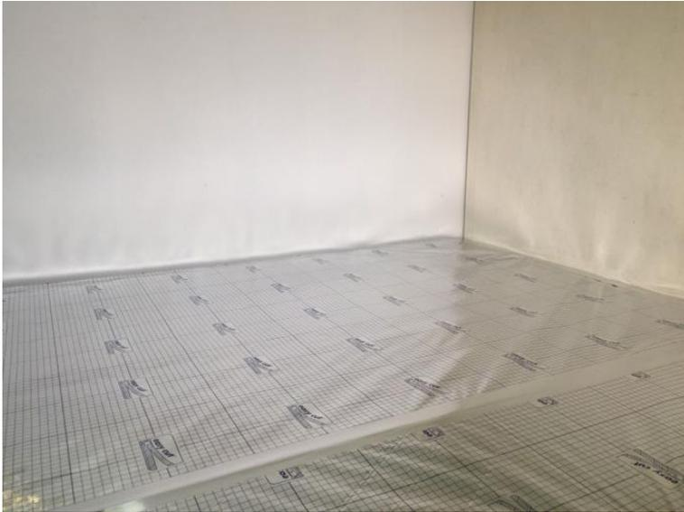
**Abbildung 12: Einbringen der Wasserdampfdiffusionssperre und Abdichten mit Alu-Band**
