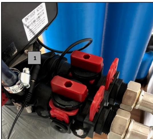
1. Abwasserschlauch 1/2" aufschieben und mit der Schlauchschelle festklemmen.
