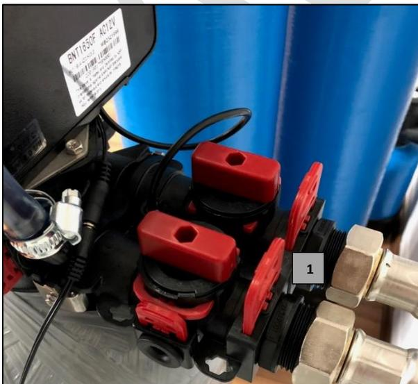
1. Steuerkopf mit Anschlussstück und Anschlussschläuchen.
