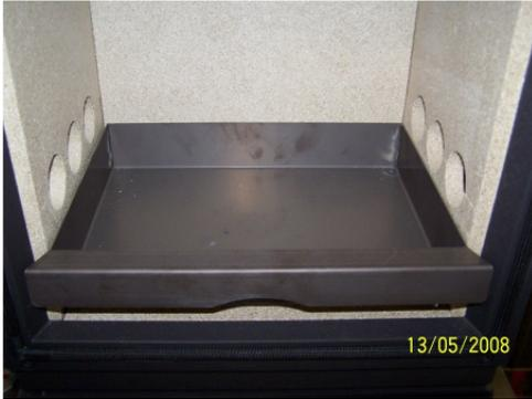
Vermiculite unten Boden herausnehmen
