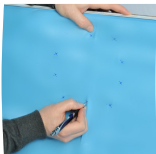
Repérez et tracez l'emplacement des vis
