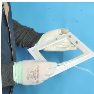
Plaats het verbindingsdeel op de flens
