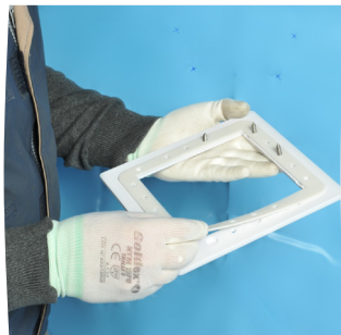
Posizionare il giunto sopra il traversino
