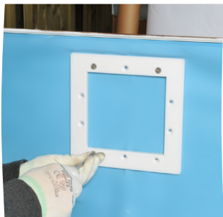
Aparafuse o flange e aligere o liner
