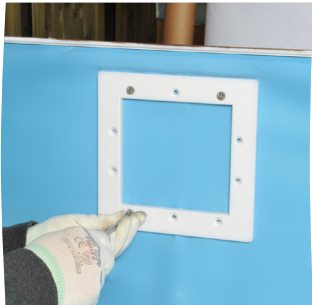
Avvitare il traversino e togliere il liner
