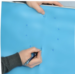
Individuare e segnalare la posizione delle viti
