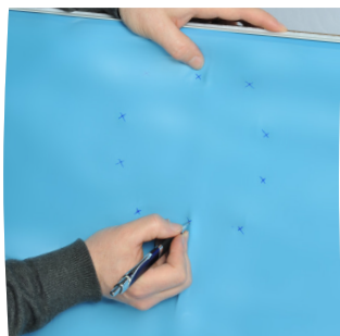
Localize e assinale a localização dos parafusos
