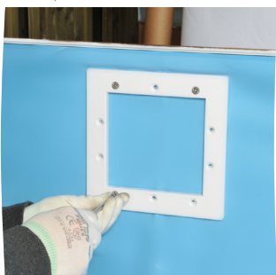
Atornille la brida y ahueque el liner
