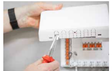
Kabeleinführung aus dem Deckel brechen.
