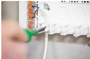
Kabel in Zugentlastung einsetzen.
