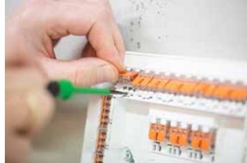
Klemme aus Aufnahme lösen.
