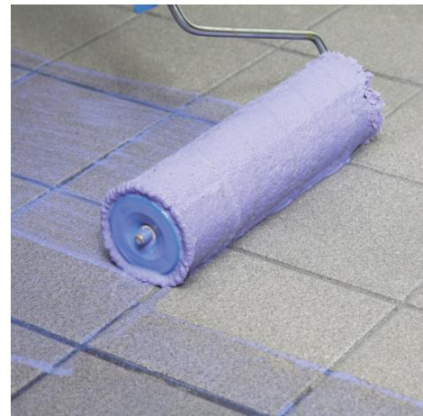
PCI Gisogrund 404 in der Kontrollfarbe violett ermöglicht eine hohe Verbundhaftfestigkeit von Ausgleichsmassen und Verlegewerkstoffen zum jeweiligen Untergrund.
