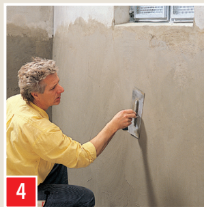
4 Mit Stahlglätter glatt ziehen. 3 Tage erhärten lassen. Danach für Folgearbeiten zu nutzen, z. B. Fliesenkleben, Streichen.
