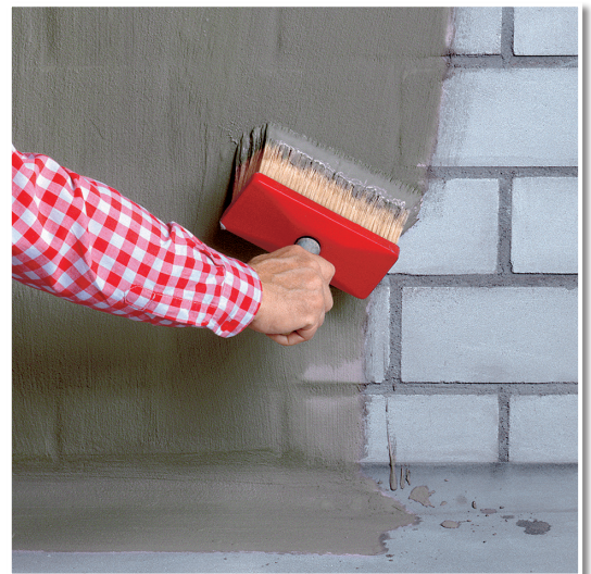
Abdichten mit TROCK'NER KELLER DICHUNGSSCHLÄMME, hier auf Kalksandsteinmauerwerk.
