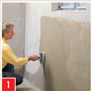
1 Erste Schicht TROCK'NER KELLER mit Quast aufstreichen.
